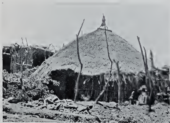
Abb. 3. Hüttenwand aus Bambusstäben.
